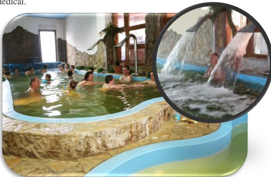
Fig. 43. Piscină termală interioară cu hidromasaj (Hotel Marissa *** ) (Sursa: http://motelmarissa.ro/ )
